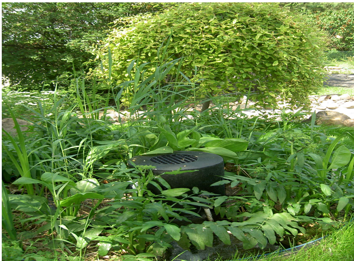
Przydomowa oczyszczalnia ścieków - hydroponiczna w Ożarowie. 1,0 - 1,5m 3 ścieków na dobę. Oczyszczona woda zasila oczko wodne (w tle zdjęcia).
