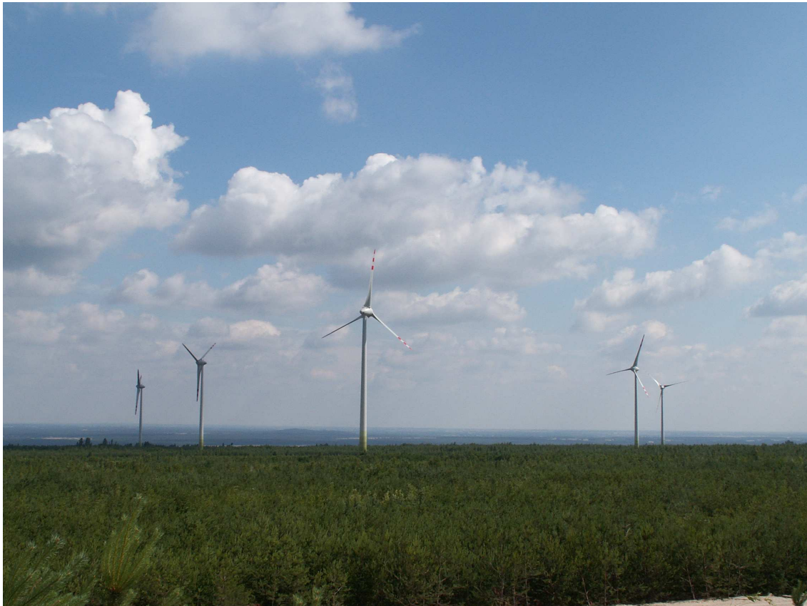
Fot. 7. Park elektrowni wiatrowych na Górze Kamięńsk
