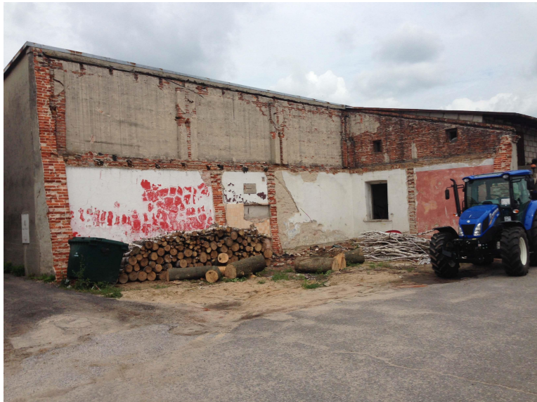
POZOSTAŁE ŚCIANY PO WYBURZONIU OD STRONY POŁUDNIOWEJ ISTNIEJĄCEGO BUDYNKU GOSPODARCZEGO
