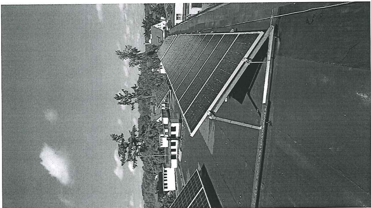
Przykładowa instalacja z ramą dla dachu płaskiego
