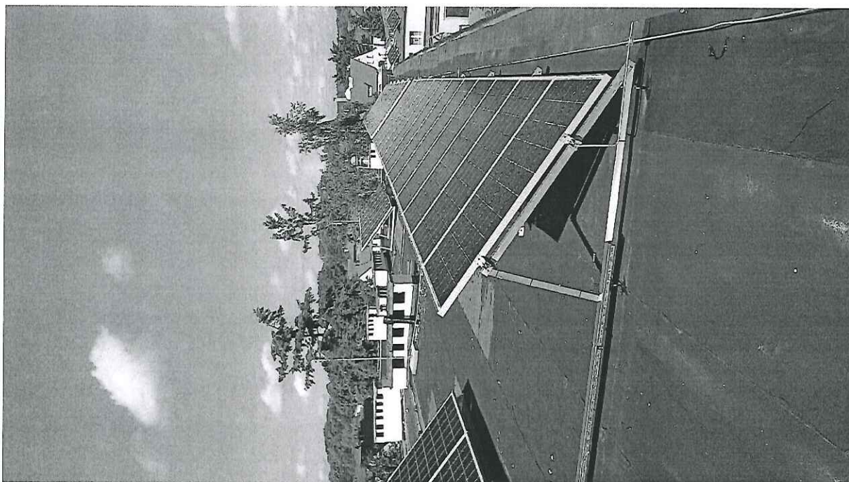
Przykładowa instalacja z ramą dla dachu płaskiego
