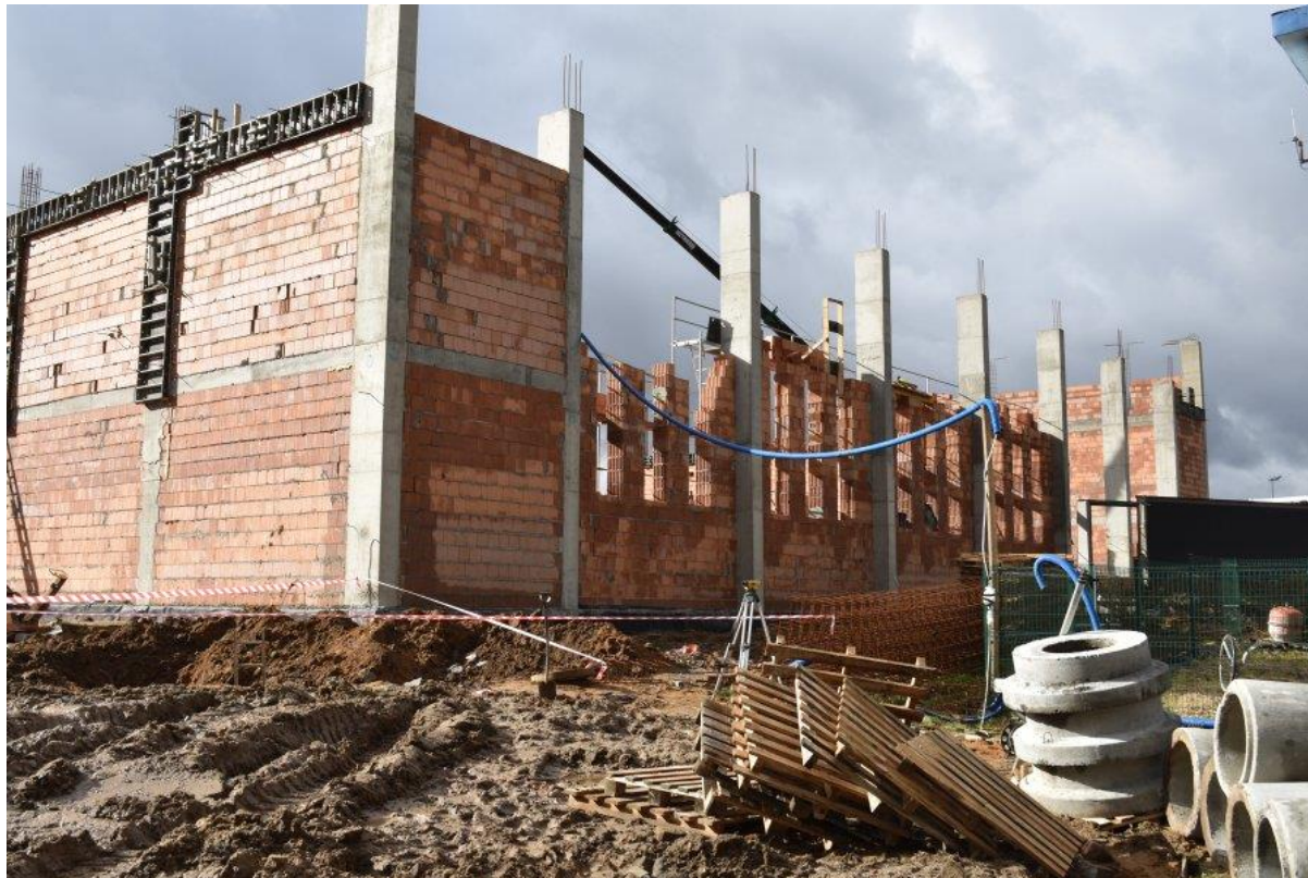
Zdjęcie. Budowa hali widowiskowo-sportowej w Kamieńsku
