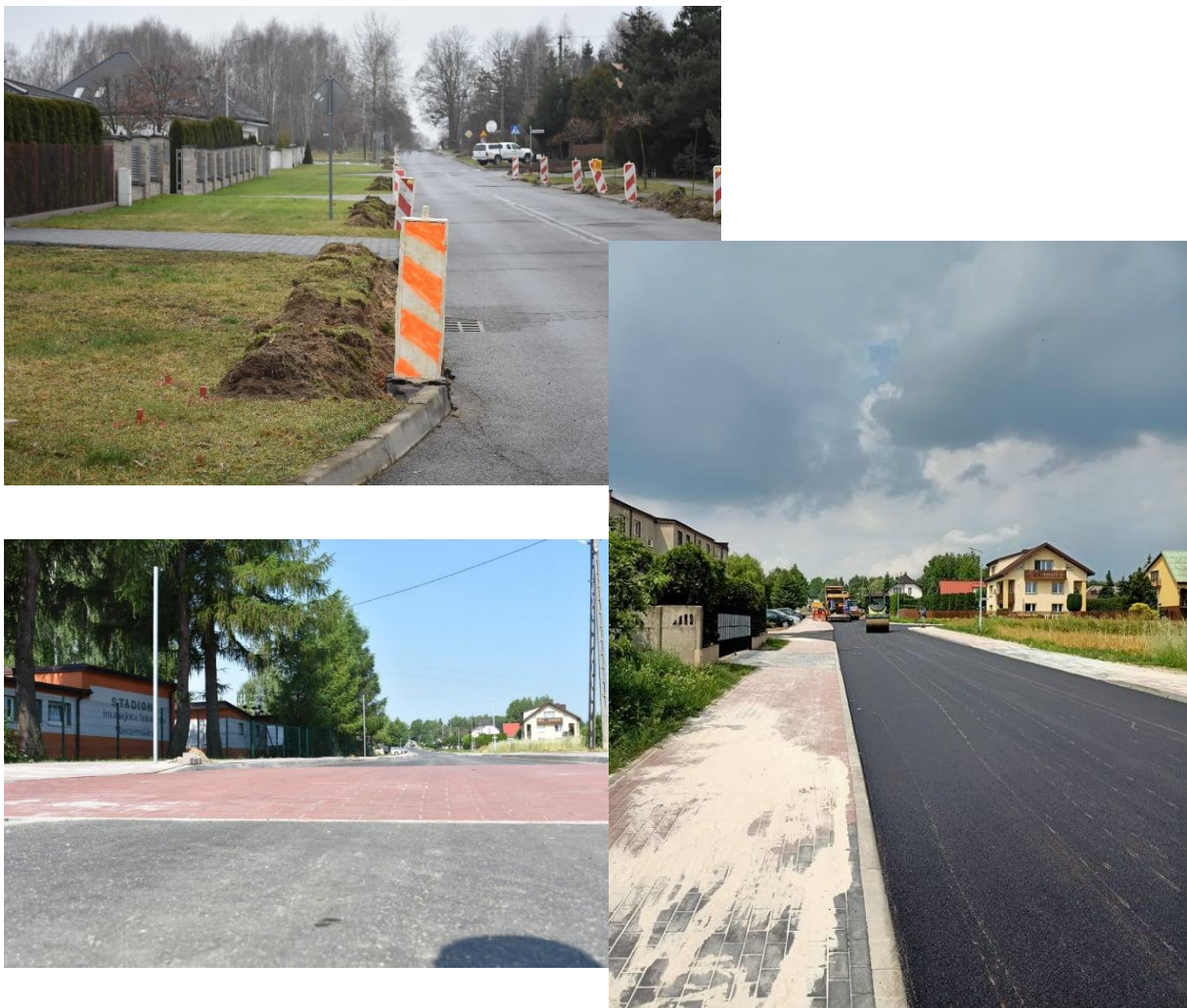
Zdjęcia. Przebudowa ul. Sportowej w Kamieńsku
