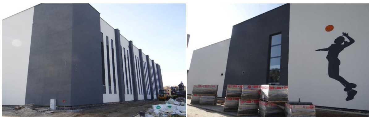
Zdjęcia: Budowa hali widowiskowo-sportowej w Kamieńsku zdjęcia z października 2022 r.
