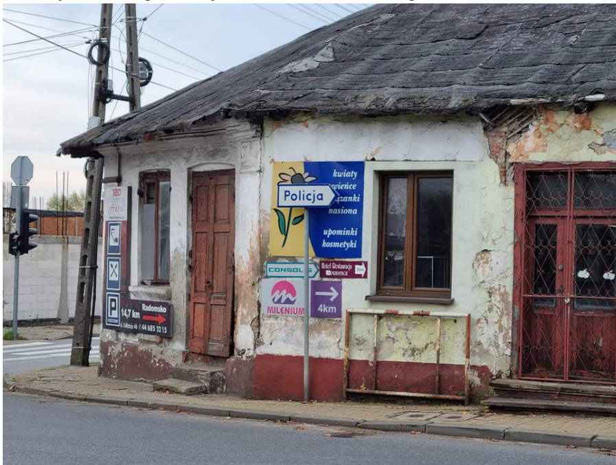
Fotografia 16 Budynek na rogu ulic Zjednoczenia i Słowackiego w Kamieńsku
