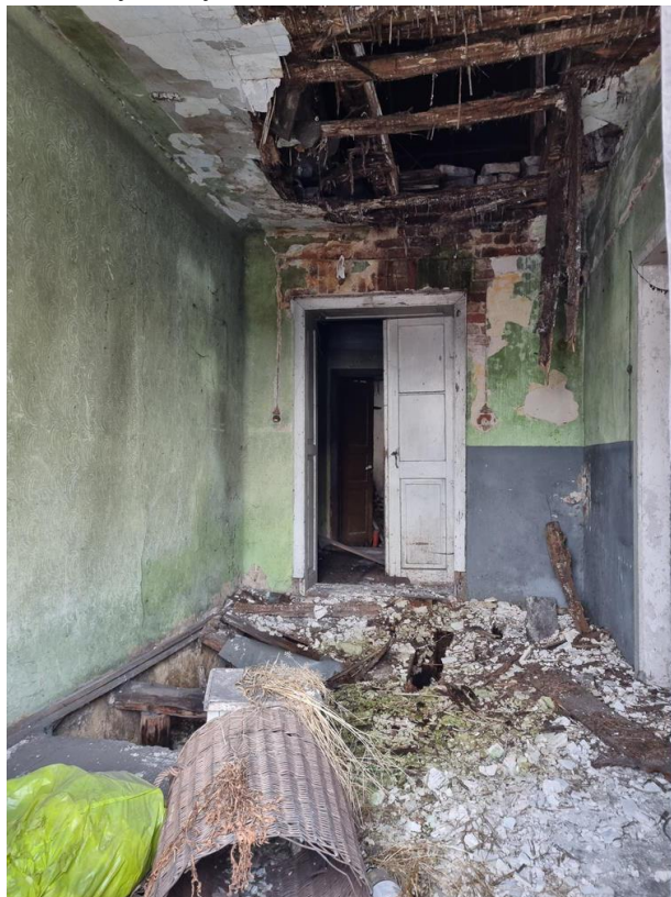
Fotografia 22 Wnętrze kamienicy do wyburzenia, Miasto Kamieńsk
