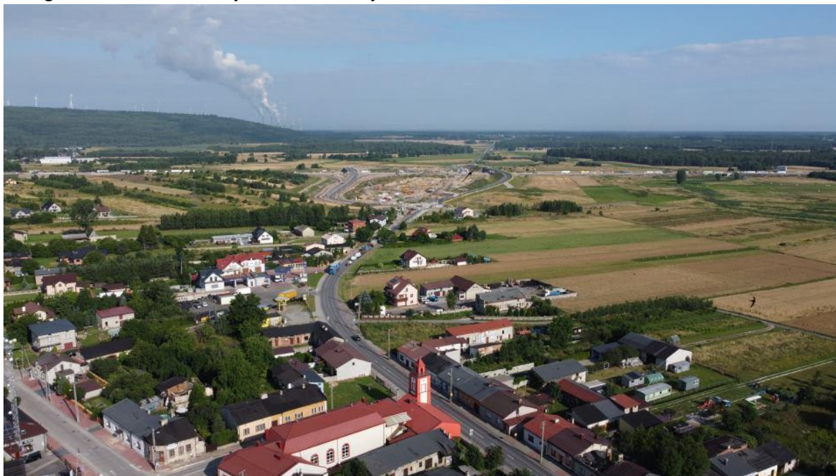
Fotografia 1 Widok na węzeł autostradowy w Kamieńsku, w tle Elektrownia Bełchatów
