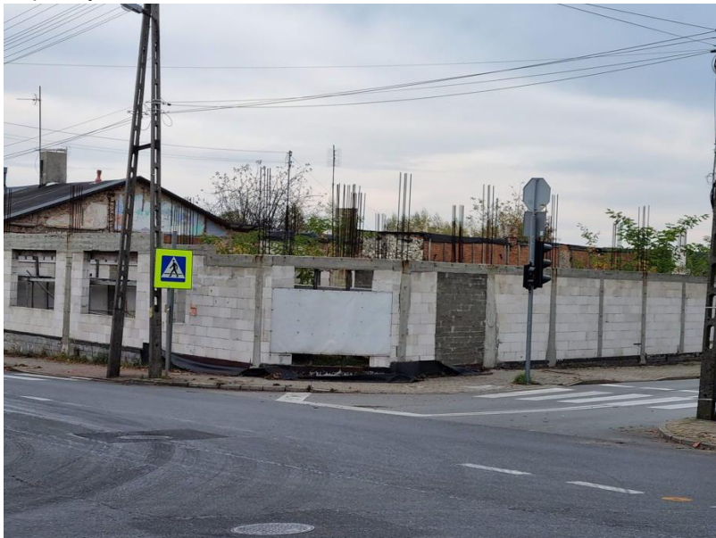
Fotografia 18 Rozpoczęta budowa, centrum Miasta Kamieńsk
