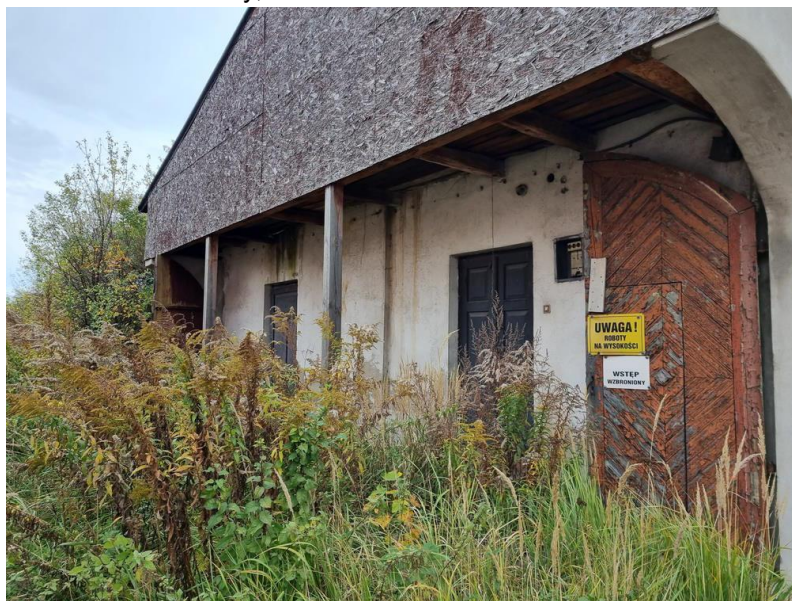
Fotografia 17 Podwórko w kamienicy, Kamieńsk
