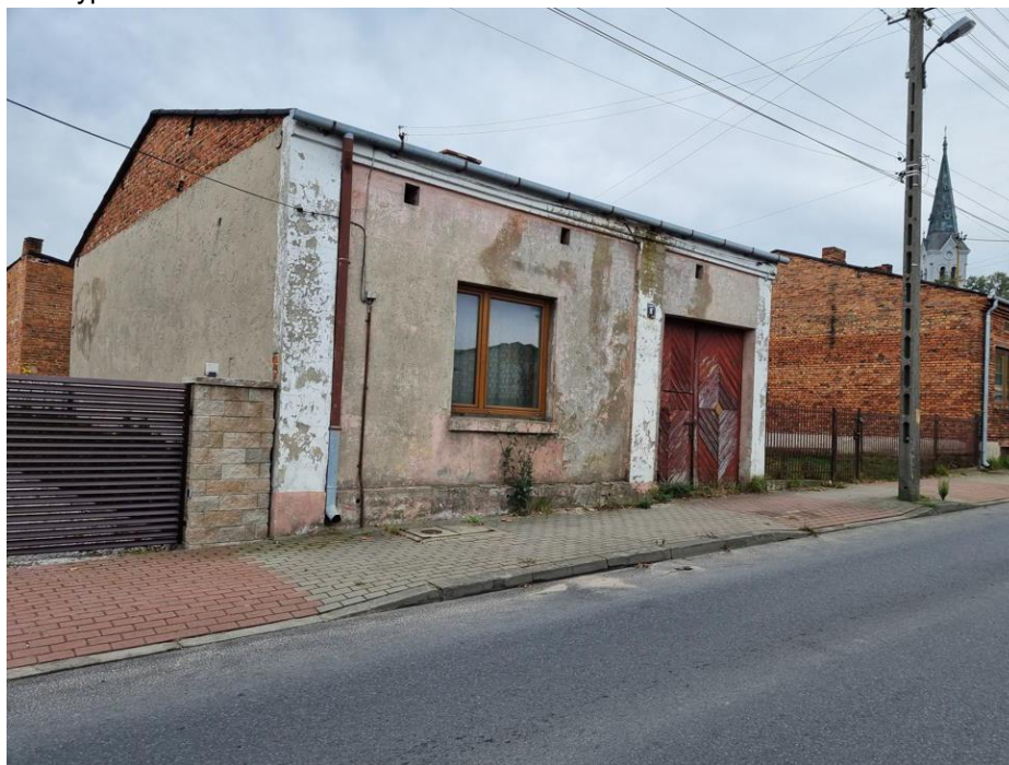
Fotografia 19 Typowe budownictwo w centrum Kamieńska
