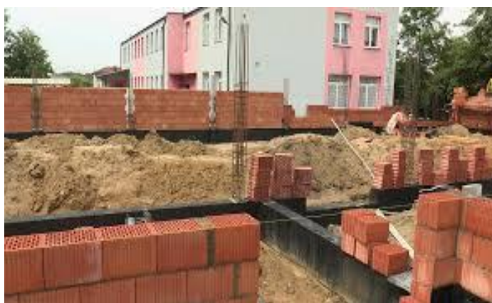
Zdjęcia: Budowa sali sportowej przy ZSP w Gorzędowie.
