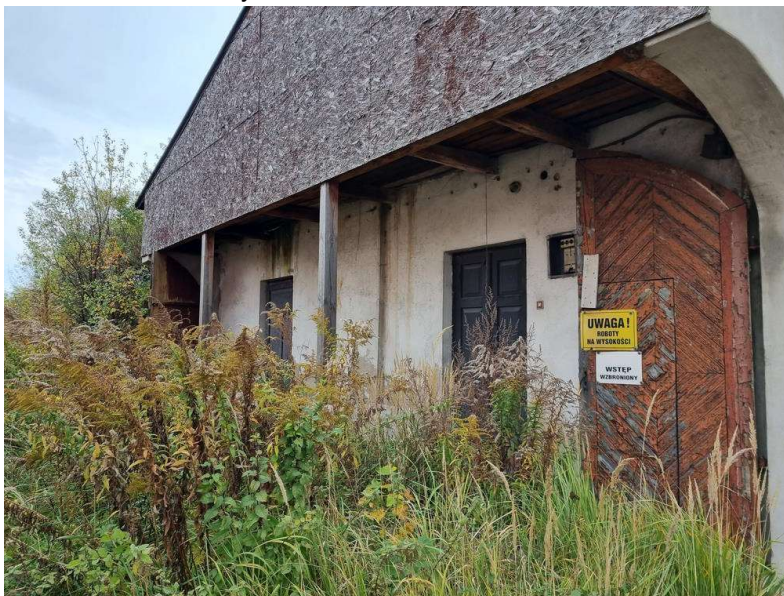
Fotografia 17 Podwórko w kamienicy, Kamieńsk
