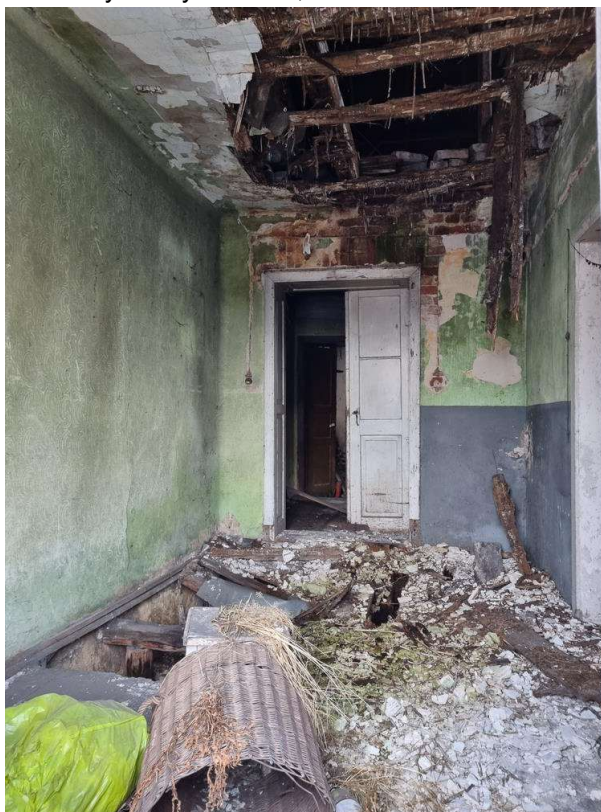
Fotografia 22 Wnętrze kamienicy do wyburzenia, Miasto Kamieńsk
