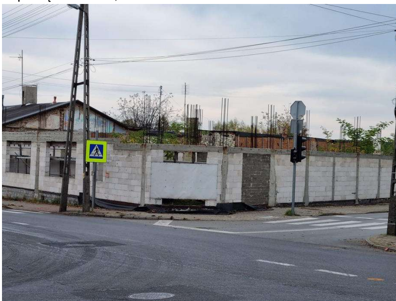
Fotografia 18 Rozpoczęta budowa, centrum Miasta Kamieńsk
