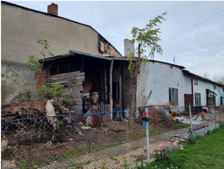
Fotografia 20 Budynki przeznaczone do wyburzenia, Kamieńsk
