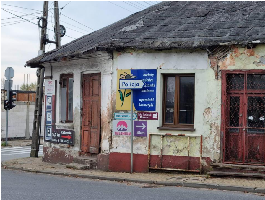
Fotografia 15 Budynek na rogu ulic Zjednoczenia i Słowackiego w Kamieńsku
