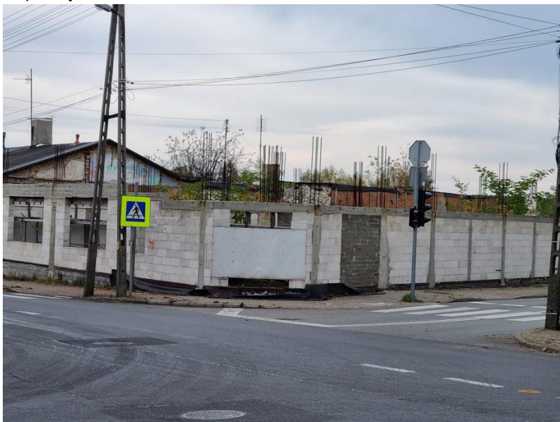
Fotografia 17 Rozpoczęta budowa, centrum Miasta Kamieńsk
