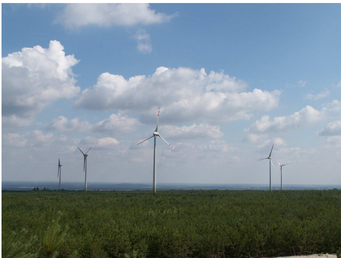
Fot. 7. Park elektrowni wiatrowych na Górze Kamięńsk
