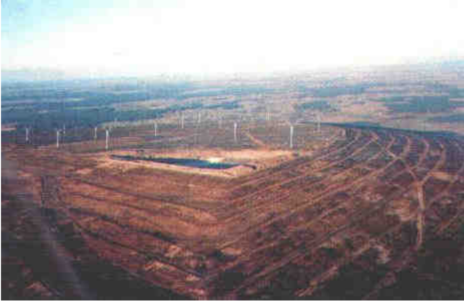
Rys. 28. Góra Kamięńsk po wybudowaniu parku elektrowni wiatrowych.
